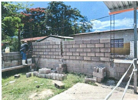
Foto 1: Área donde se está ejecutando el mejoramiento de muros perimetrales mediante el levantado de block de concreto.
